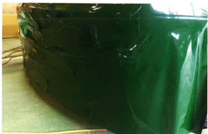
シートの端部は極力伸ばさず、カットした形状を保つように施工すれば剥離は起きにくい。
