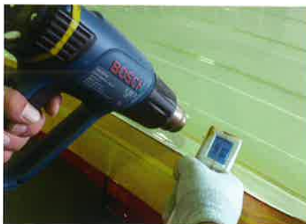
フィルムの表面温度を確認しながらのポストヒーティング。
